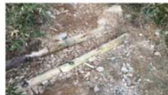
ステップアンドプールのにより、侵食を抑えた排水構造とする
