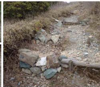
ステップアンドプールのにより、侵食を抑えた排水構造とする
